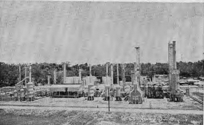
Vista general de las instalaciones de "Refinadora Costarricense de Petróleo" donde se iniciarán ya las pruebas finales para la obtención de gasolina, diesel, cañin y otros derivados del petróleo. Ya está en Costa Rica el primer embarque de materia prima (crudo) para iniciar después la producción.
